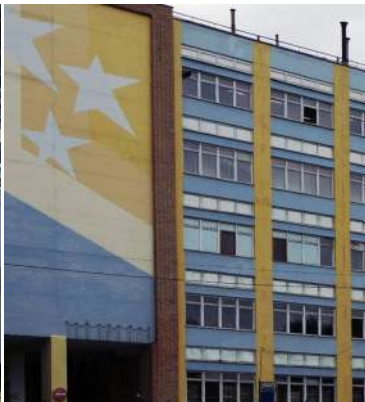
Завод кондитерских изделий «Fazer» г. Москва
